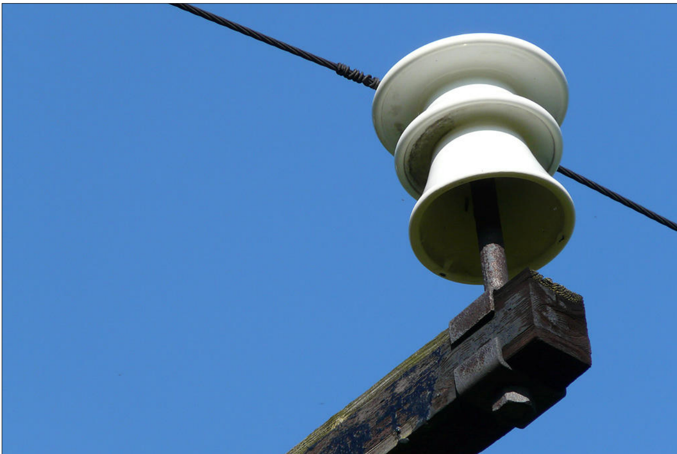
Obr.3 – Detail izolátoru a upevnění na konzole
