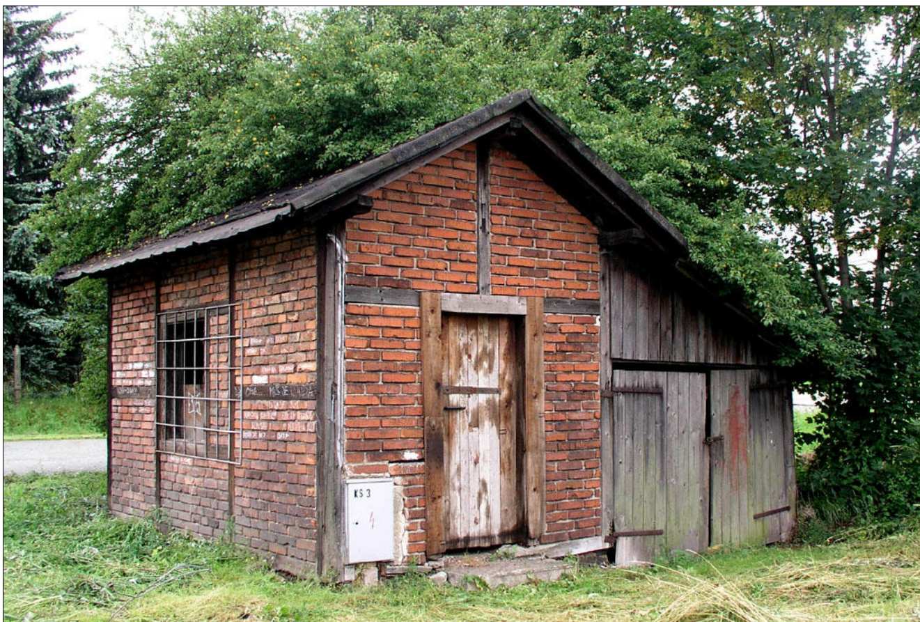
Obr.1 – Fotografie předlohy – pohled na čelní stěnu
